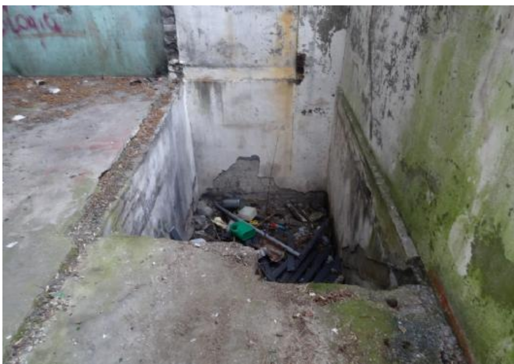
Zdjęcie 6. Hala żelbetowa – brak schodów wejścia do piwnic.
