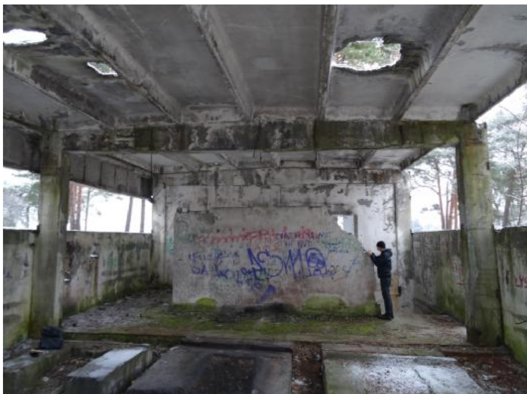
Zdjęcie 7. Hala żelbetowa – płyty stropu w bardzo złym stanie; posadzki żelbetowe z blokami betonowymi pod urządzenia.
