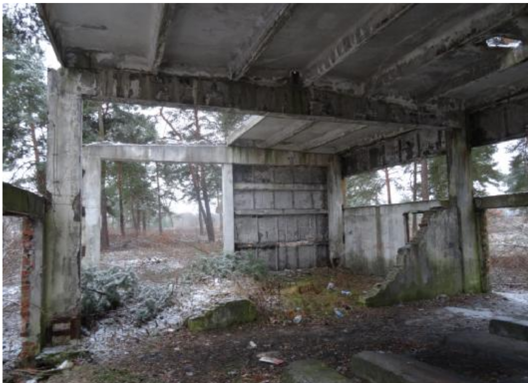
Zdjęcie 5. Hala żelbetowa – zarwane płyty prefabrykowane; nadproża żelbetowe w złym stanie oberwane w elewacji zachodniej.
