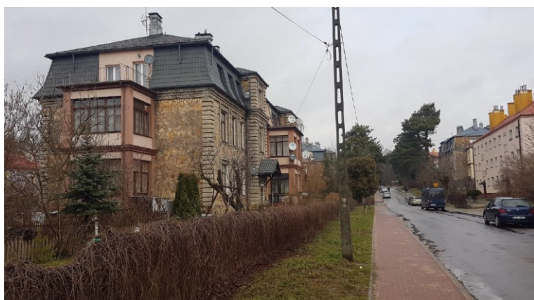
Fotografia 3. Widok na budynek mieszkalny wielorodzinny przy ul. Tytusa Chalubińskiego 6 [fot. Archiplaneo Karol Skuza 2022 r.]
