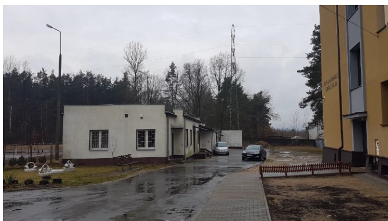
Fotografia 2. Widok na obiekt Zespołu Placówek Edukacyjno-Wychowawczych, ul. Szkolna 14; po prawej budynek internatu, ul. Szkolna 16 [fot. Archiplaneo Karol Skuza 2022 r.]
