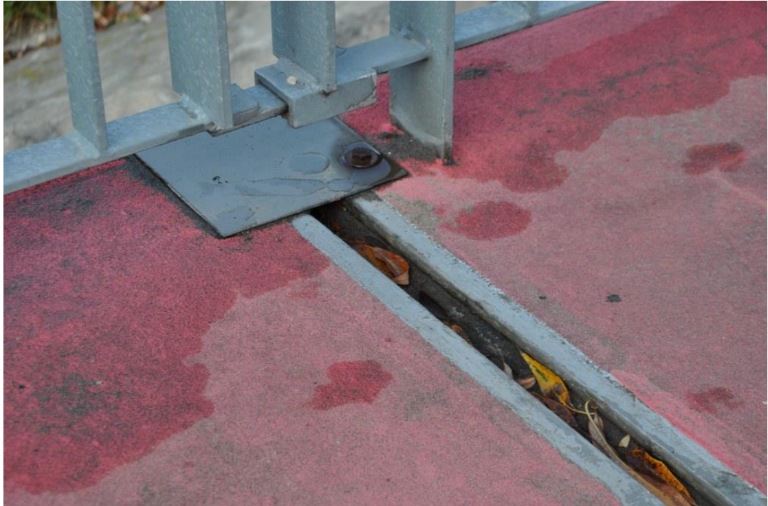
Zdjęcie nr 9 – Blacha maskująca w miejscu dylatacji modułowej.
