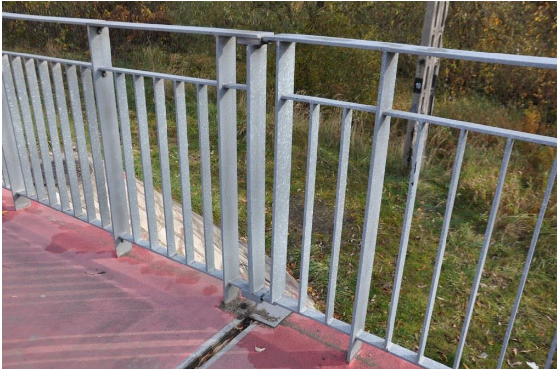
Zdjęcie nr 8 – Widok na balustradę stalową z płaskowników w miejscu dylatacji obiektu.
