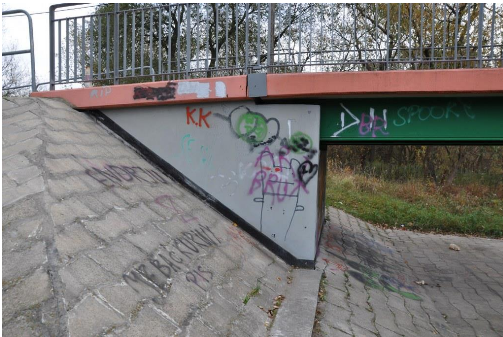
Zdjęcie nr 1 – Widok na przyczółek w osi nr 1.
