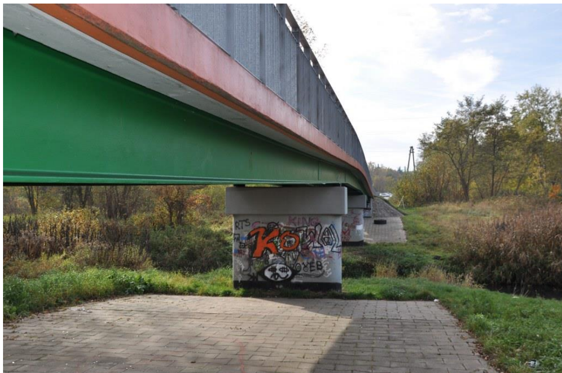
Widok ogólny obiektu
