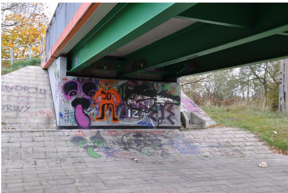
Zdjęcie nr 2 – Widok z przodu na przyczółek w osi nr 1.
