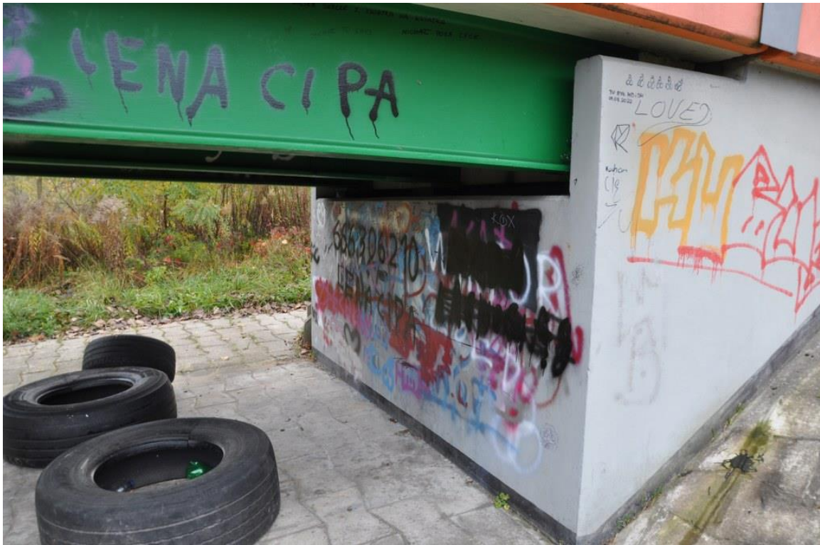
Zdjęcie nr 5 – Widok na przyczółek w osi nr 4.
