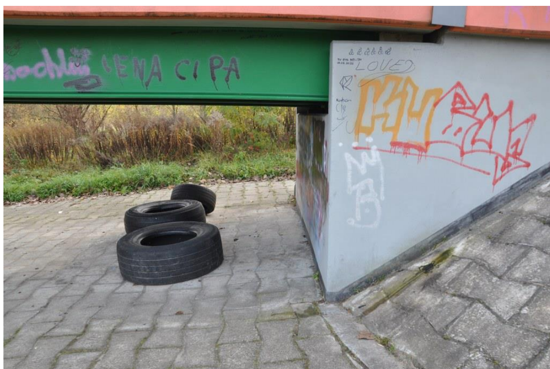
Zdjęcie nr 4 – Widok na przyczółek w osi nr 4.
